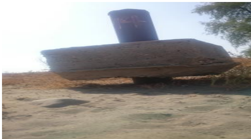
شکل ۹- بالا آمدگی چاه پیزومتری شماره ۱۴.
