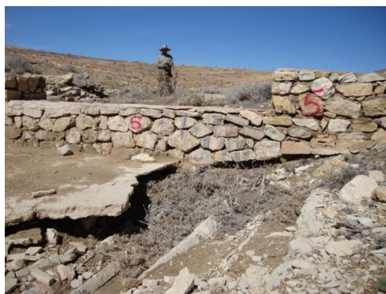
شکل ۴- تخریب پاچین بند شماره ۵.
