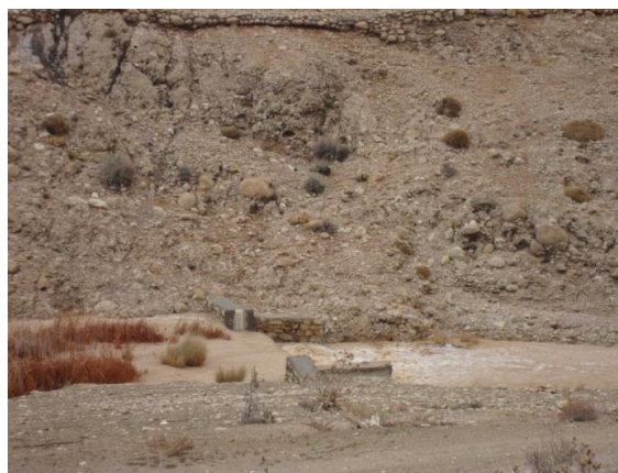
شکل ۶- عبور کردن سیل از سرریز بند P 11 و پایداری آن.
