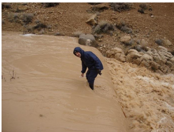
شکل ۷- تکیه‌گاه مناسب بند ۳۷ و پایداری آن
