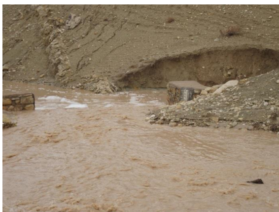
شکل ۵- تخریب پایاب بند شماره ۲۷.
