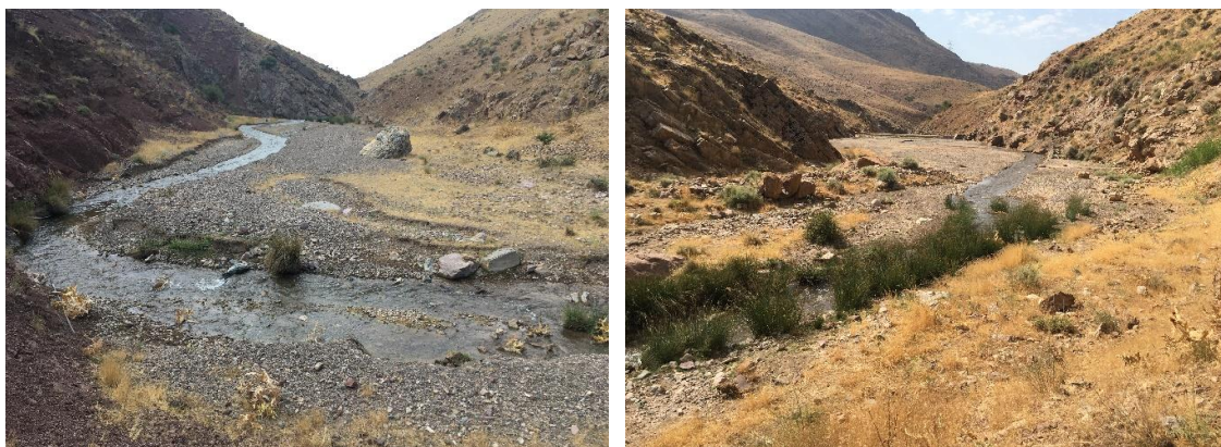
شکل ۷- رسوب‌گذاری در سازه‌های آبخیزداری در آبخیز فشد.
